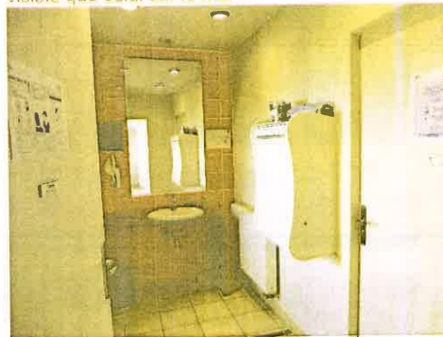
Il y a une porte pour le sas avec lavabo et une porte pour l'accès aux toilettes. Ajouter un picto PMR sur chacune des portes. Ajouter une barre de tirage sur chaque porte située entre 0.70 et 1.05m.
