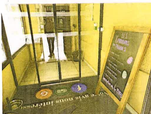
2 éléments de repérage situés à 1.20m et 1.60m // (norme 1.10m)
