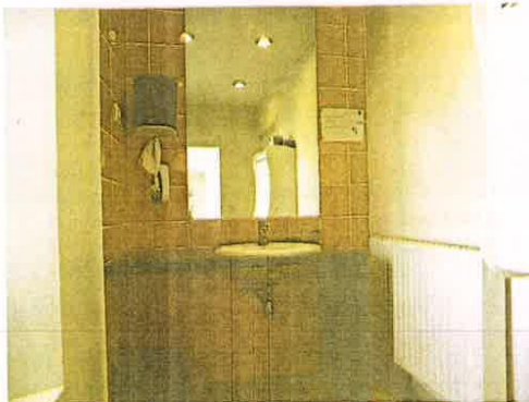
Déplacer le distributeur de papier vers la droite et à une hauteur entre 0.90 et 1.30. Robinetterie à levier ne présente pas clairement chaude et l'eau froide.
