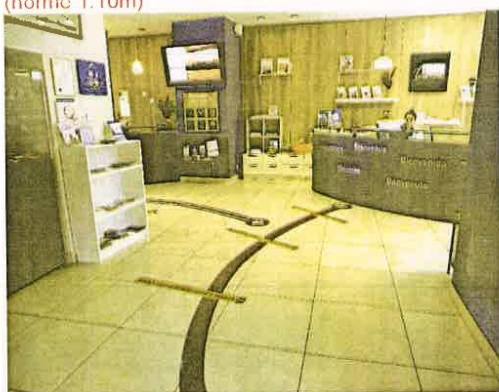
Les cheminements sont larges et visuellement repérables par une bande constrastée au sol
